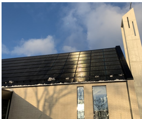
Soltaket (sørsiden). Foto: Ardon Kaerma
